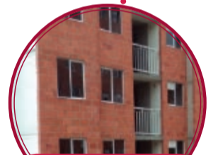
Proyecto de vivienda El Socorro $18.900 millones
